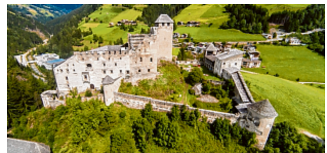
Burg Heinfels wird gerade renoviert. In einem Jahr soll das frisch sanierte und umgebaute Kleinod eröffnet werden. Foto: Brunner Images
